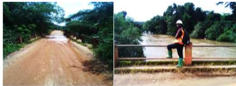
Figure 3 : Vue panoramique du pont de la Lokundjé
